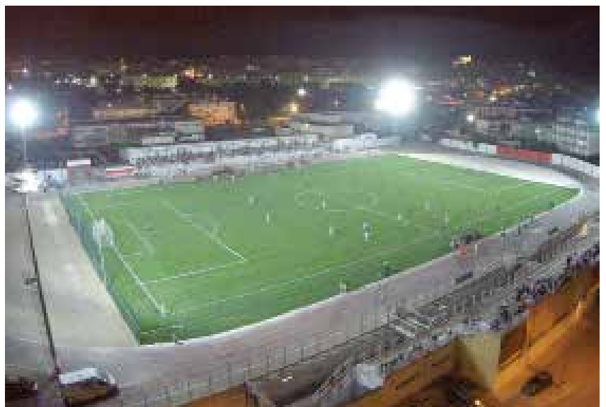
Panoramica aerea del nuovo manto in erba sintetica - Foto Felice Monopoli
